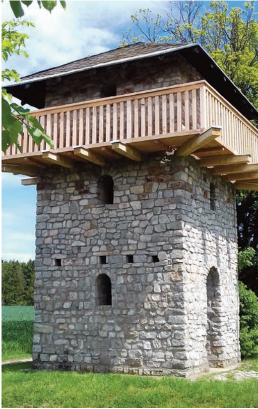
Römischer Wachturm bei Dill
