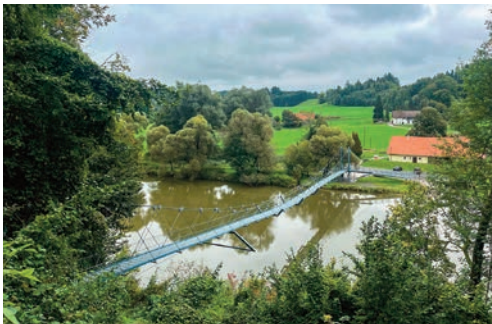
Spannende Brücke über die Iller.
